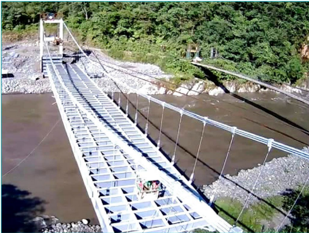
CONSTRUCCIÓN DEL PUENTE SOBRE EL RÍO PASTAZA PASO A LA PARROQUIA CUMANDA Cantón Palora
