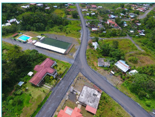
ASFALTADO PROAÑO - PACCHA, cantón Morona
